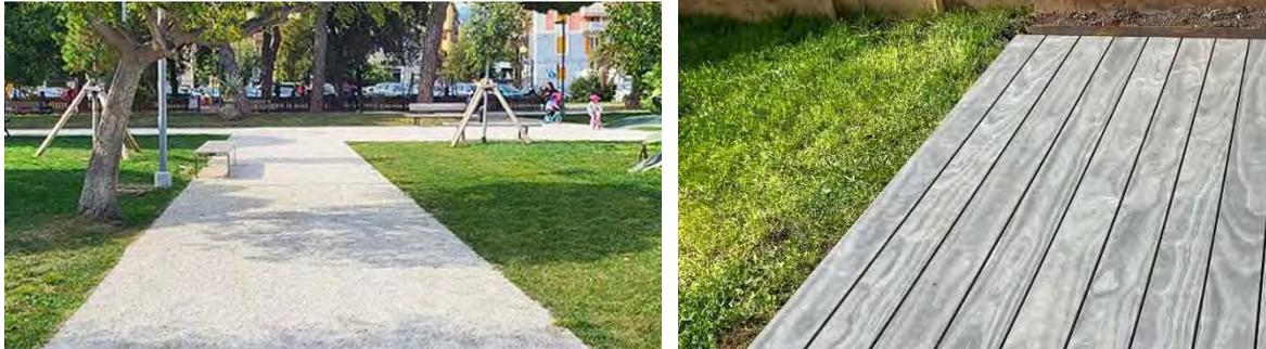
L'attuale percorso principale de-pavimentato e realizzato in calcestre costituisce l'unico accesso carrabile all'area. La soluzione tecnologica adottata garantisce inoltre la carrabilità necessaria per l'accesso di mezzi per l'allestimento di eventi e le opere di gestione e manutenzione del verde in corrispondenza del percorso in calcestre.
