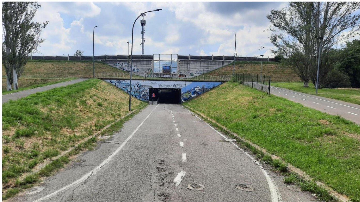
Rampa lato ovest
